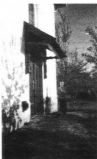
Kocsord, unitárius templom. A nemrég felújított oldal, bejárati ajtó és faragott eres.
