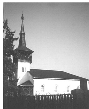
Kocsordi templom (felújítás előtt)
