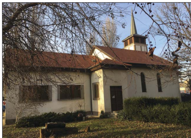
A teljesen felújított torony és tetőszerkezet
