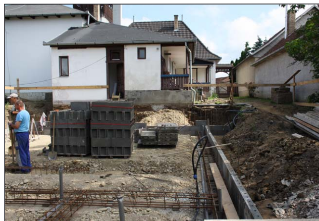
Megkezdődött a kocsordi unitárius központ építése
