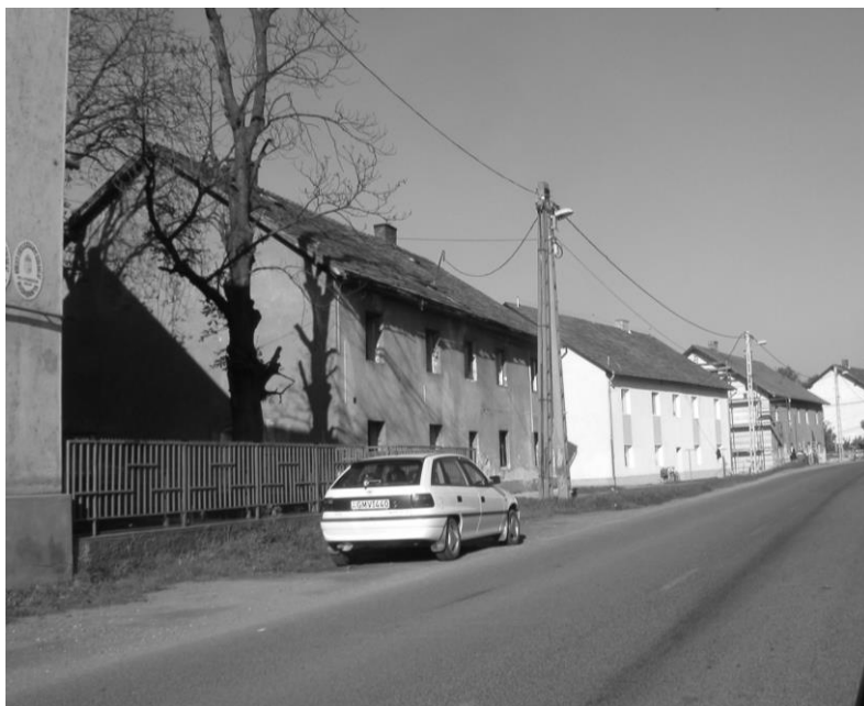
6. ábra: Az egykori bányász sorházak rehabilitációja, Rudabánya (2010).
