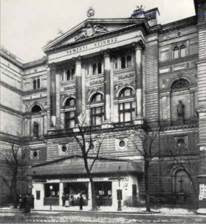
A Nemzeti Színház új homlokzata
