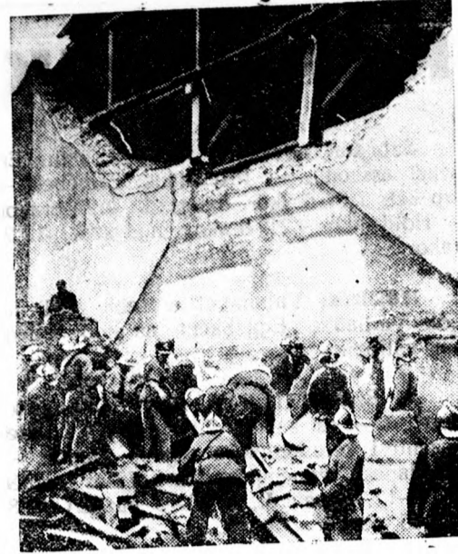
A varsói házbeomlás, melynél — mint jelentettük — 18 ember meghalt, 20 súlyosan megsebesült. A szerencsétlenséget az okozta, hogy egy gyár tűzfala rázuhant a szomszédos munkásbérház tetőzetére.
