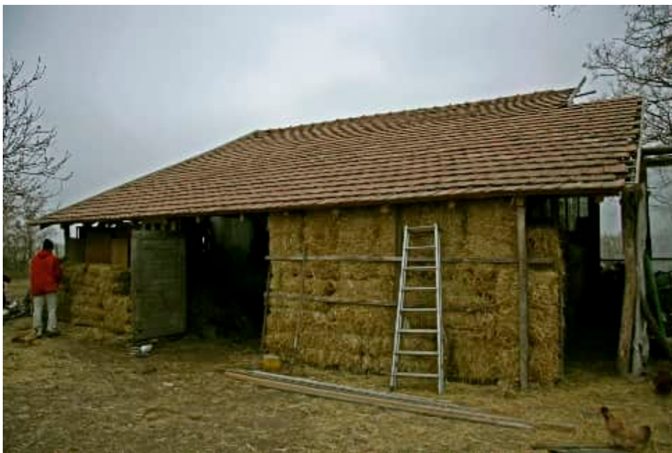
Istálló szalmabála hőszigetelése. 2011, Gátér. Fotó: Holczer Veronika
