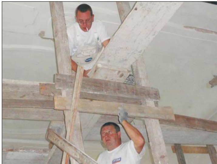
Nagypáli segítség a szászcsávási templom felújításán.
