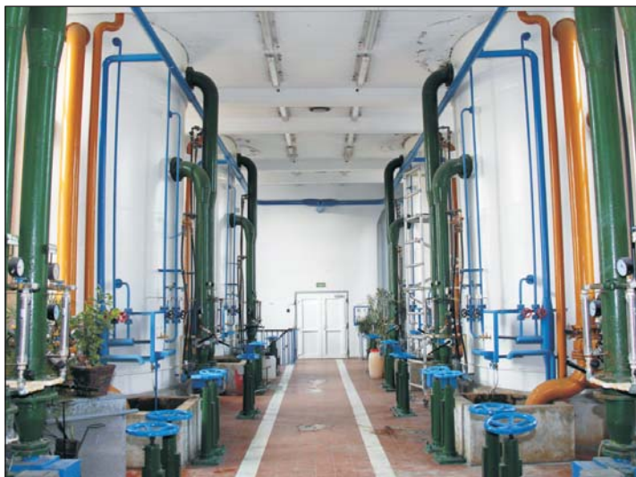
A zalaegerszegi Keleti Vízisztítómű szűrőtartályai.
