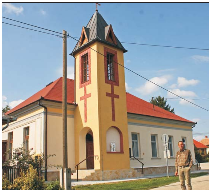
A felújított iskolatemplom mellett Vincze Ferenc polgármester ismertette az elvégzett munkákat.
