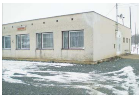
Ráfér a felújítás.
