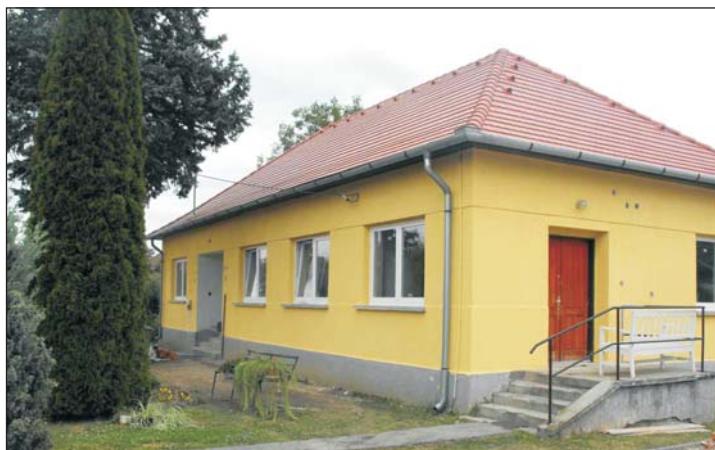
A közösségi ház felújítás közben.
