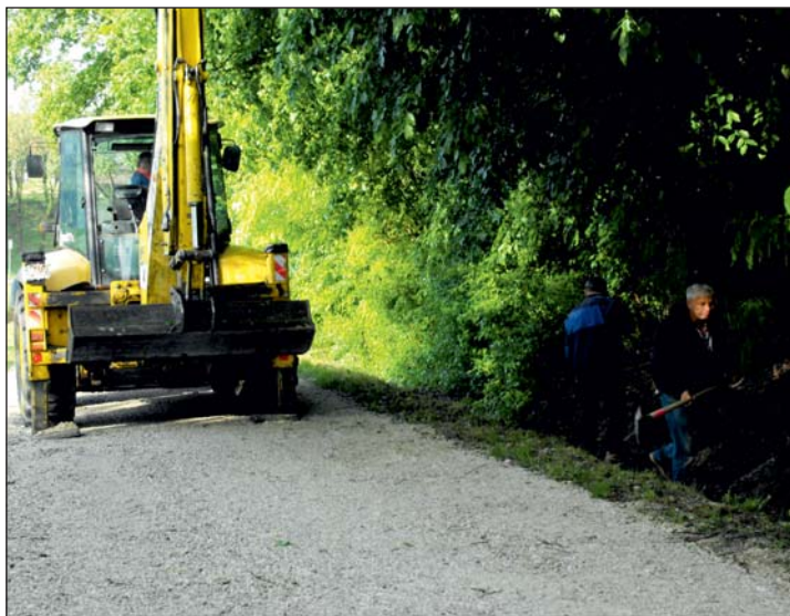
Megkezdődött a helyreállítás.
