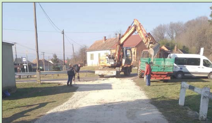
Elvégezték a bekötő utak felújítását.
