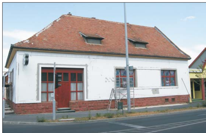
Jelenleg a Véndiófa épületének felújítását végzik.
