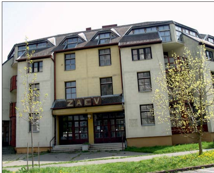
Hamarosan kezdődik az egykori ZÁEV munkásszálló felújítása.
