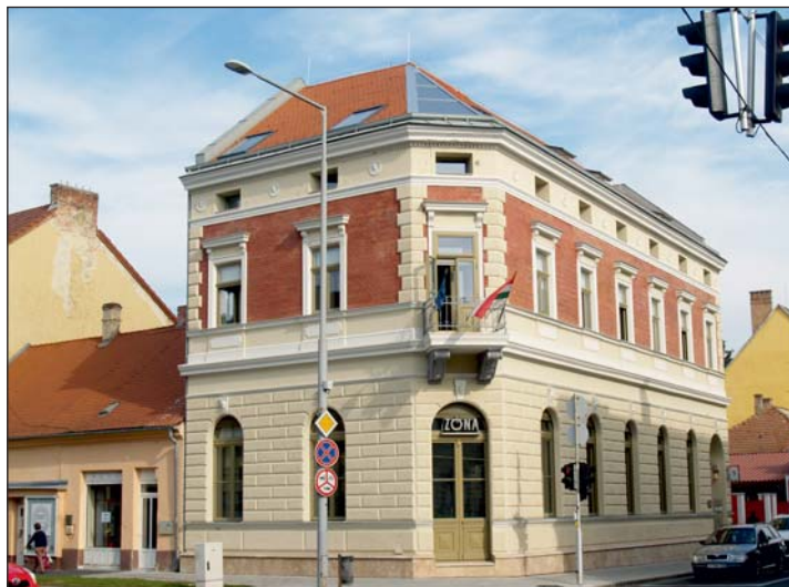
A felújított Zóna épületet április 3-án adták át.
