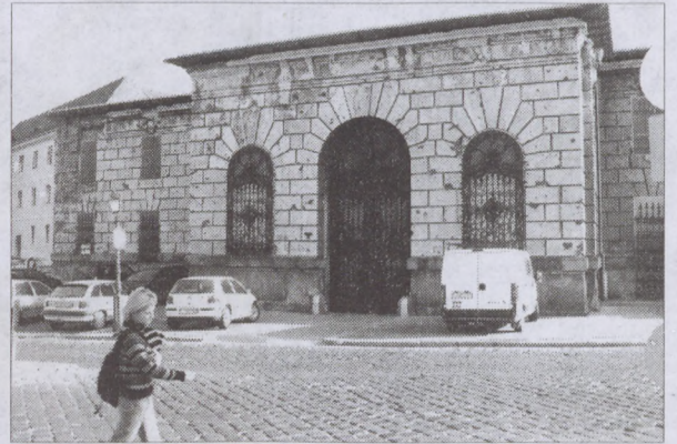
Évtizedek óta vár felújításra a volt Honvéd Főparancsnokság épülete
