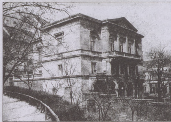
Az eredeti Ybl-féle villa A Dunára néző főhomlokzatot a kivételes panoráma miatt sűrűn elhelyezett ablaknyílások törték át, míg a többi oldal nagy zárt felületeket hordozó homlokzat volt. A főhomlokzatot a középső és a felső szinten erkélyek tagolták, felettük az épület középső részén tünpanon emelkedett. Az utcai oldalon lépcső vezetett a felső szinten lévő teraszhoz.
