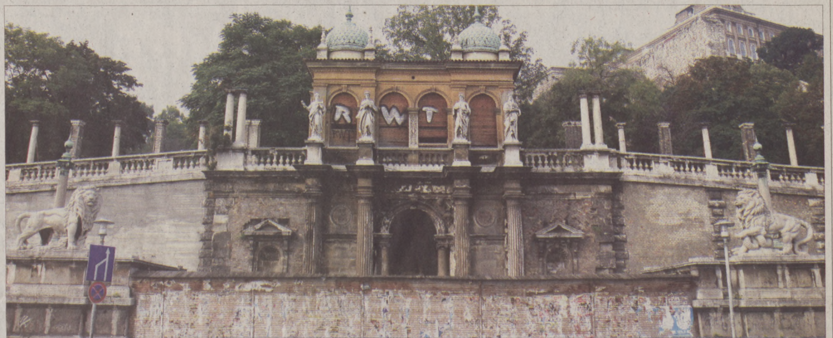
A képviselők többsége a műemlék épület állami felújítása mellett foglalt állást
