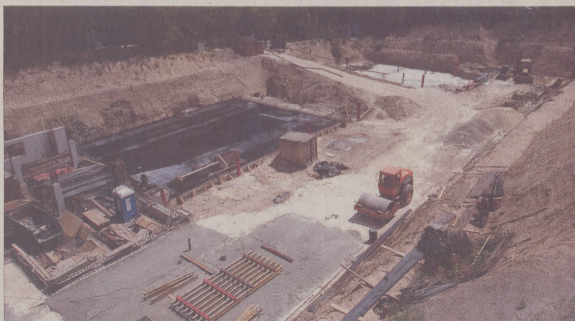
Jelenleg az oldalfalak betonozása folyik a Czakó utcai építkezésen
