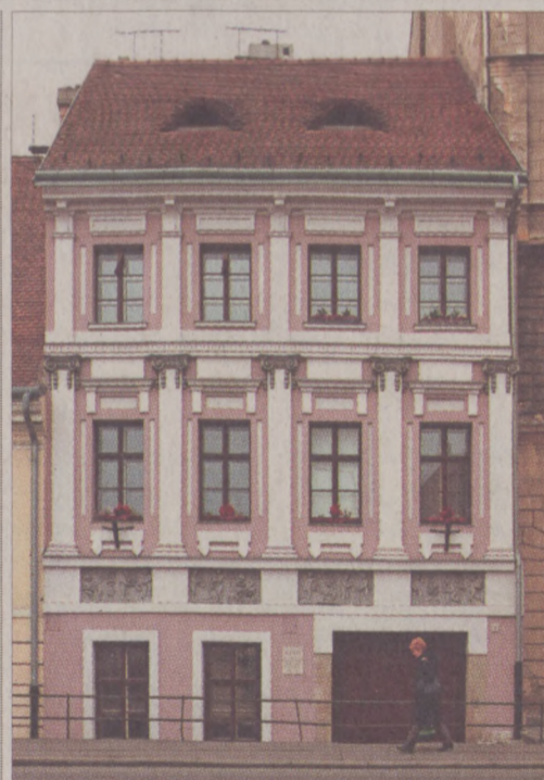
A műemlékházak felújítását tudományos kutatás előzte meg. Képközpön a Battbyány tér 3. szám alatti épület
