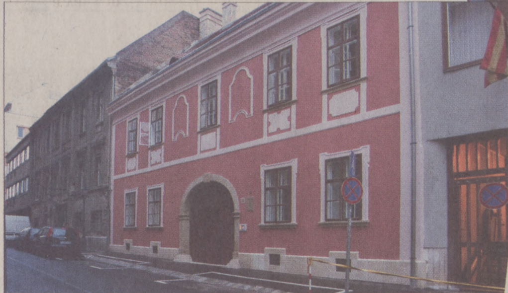
Az Iskola utca 14. megszépült homlokzata
