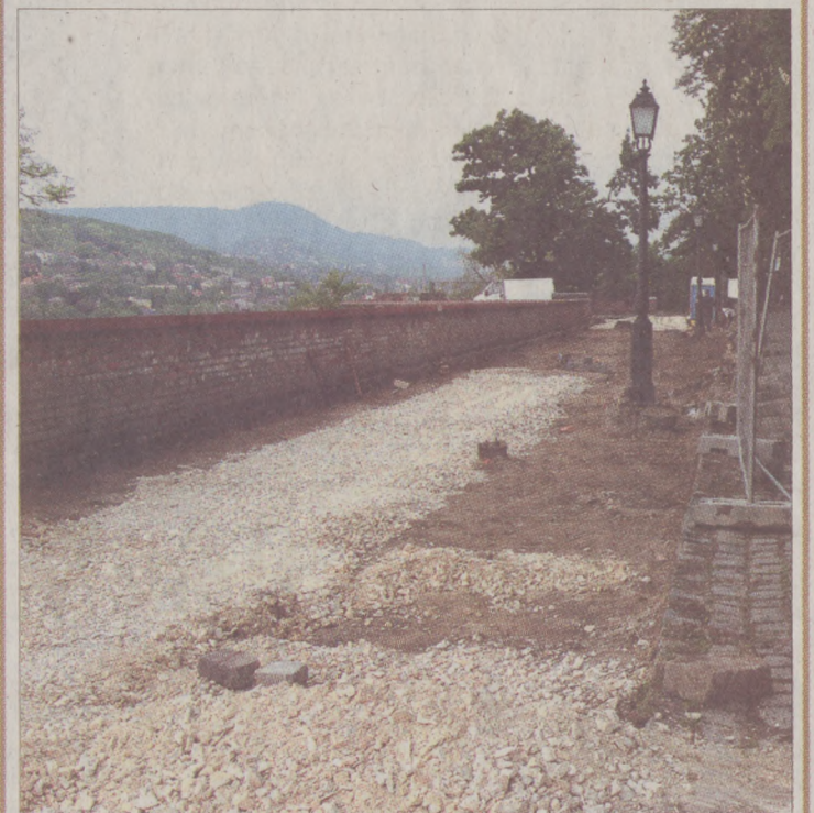
Bontják az aszfaltot a Tóth Árpád sétányon. Ezt követően új burkolat kerül a sétány Szentháromság utca és a Nőegylet utca közötti szakaszára. A felújítást a Budavári Önkormányzat megbízásából a Laki Zrt. végzi.
