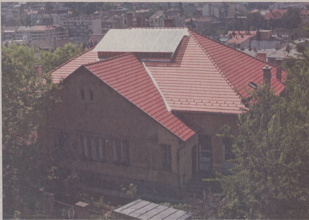
A Lovas úti óvoda teljes tetőszerkezetét átépítették a nyáron
