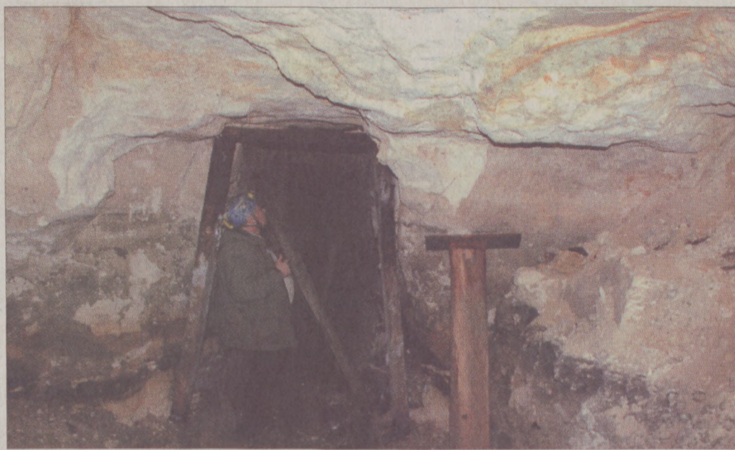
Tavasszal kezdődik a Vár alatt húzódó barlangrendszer megerősítése
