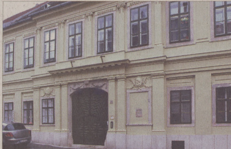
Elkészült az Országház utca 24. számú ház külső felújítása
