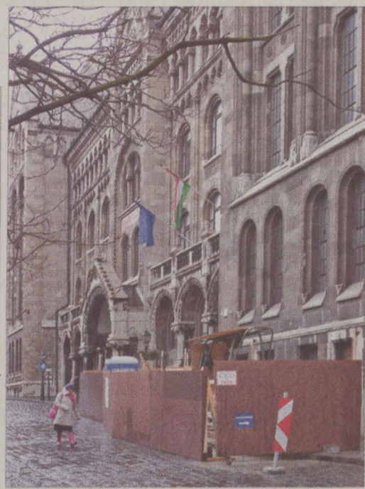
A Bécsi kapu tér alatti üregek rekonstrukciós munkáin jelenleg is dolgoznak a szakemberek
