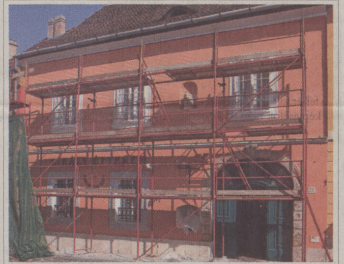
Idén is 50 millió forinttal támogatja a Budavári Önkormányzat a kerületi társasházak felújítását
