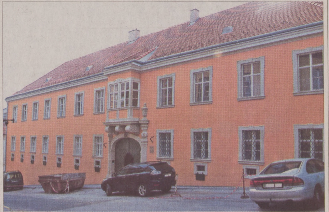
A Pala utca 8. számú épület homlokzatát és tetőszerkezetét is felújították
