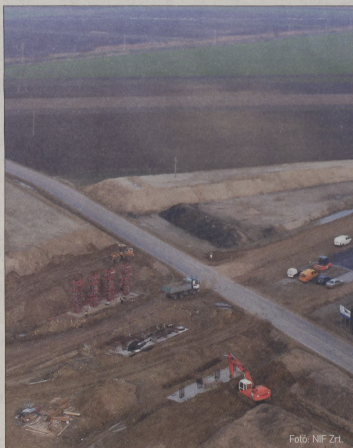
Az M43-as autópálya építése
