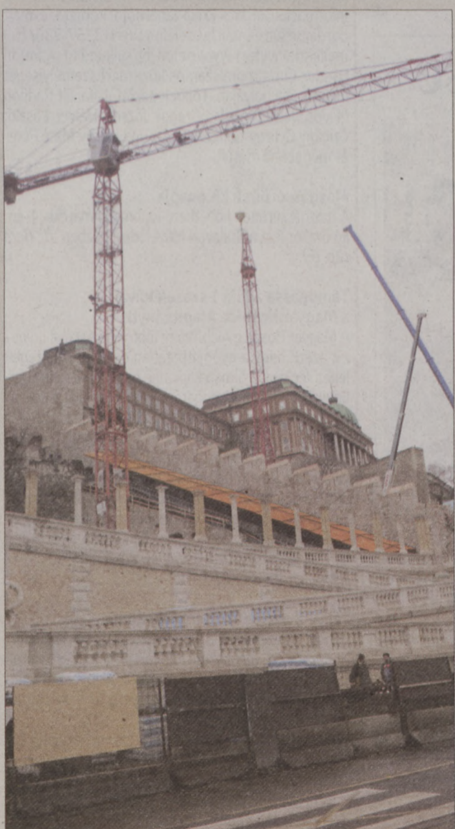
Jól halad az építkezés a Várkert Bazár területén. Már megkezdtek a munkások az építési daruk elbontását
