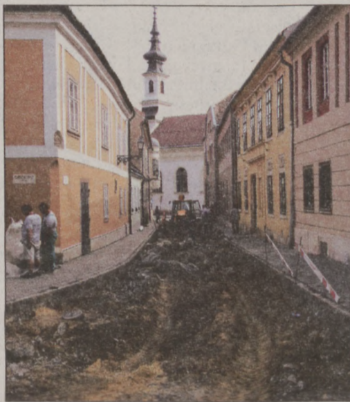
A Kard utca felújítása is folyamatosan halad, a járdabontással már elkészültek, jelenleg a szegélyépítés folyik. Erre a beruházásra 31 millió forintot fordít a Budavári Önkormányzat.
