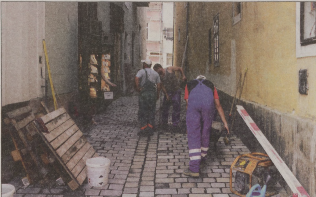
Megkezdődött a Hajadon utca felújítása is. A munkálatok során vágott nagykokkakkal burkolják le a Tárnok utca és az Uri közötti Hajadon utcát. Az 5,5 millió forint értékű felújítási munkálatok augusztus közepéig tartanak.
