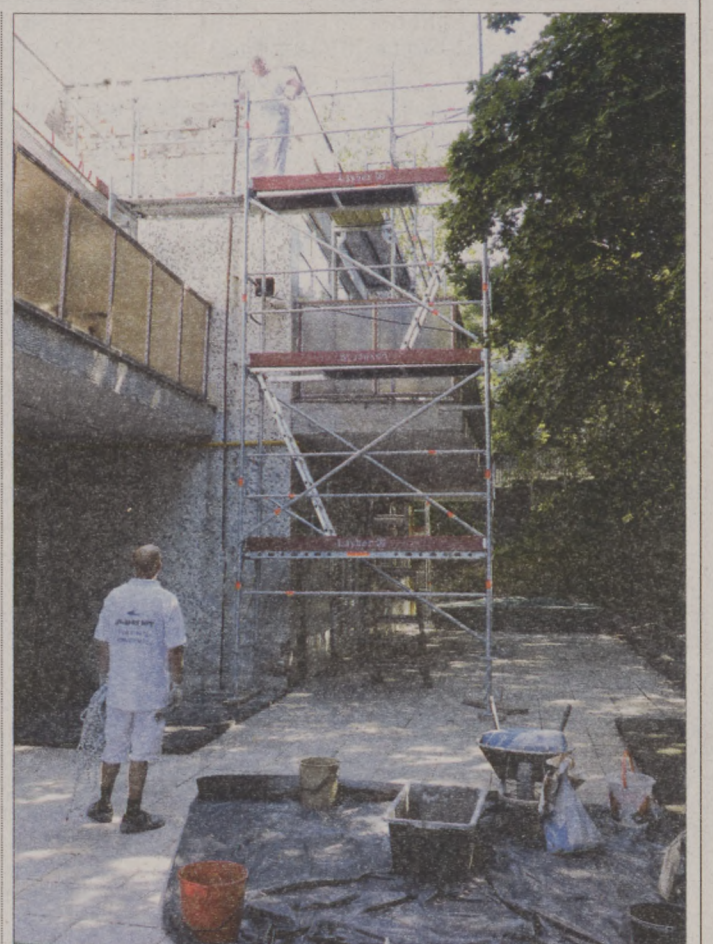
A Nyárs utcai óvodában egyebek mellett elvégzik a homlokzat és a fűdém utólagos hőszigetelését is
