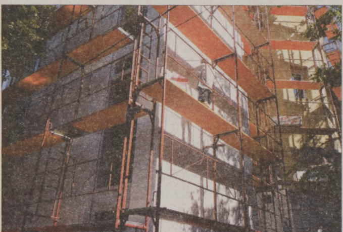
Szeptember közepére készül el a Mészáros utcai óvoda korszerűsítése
