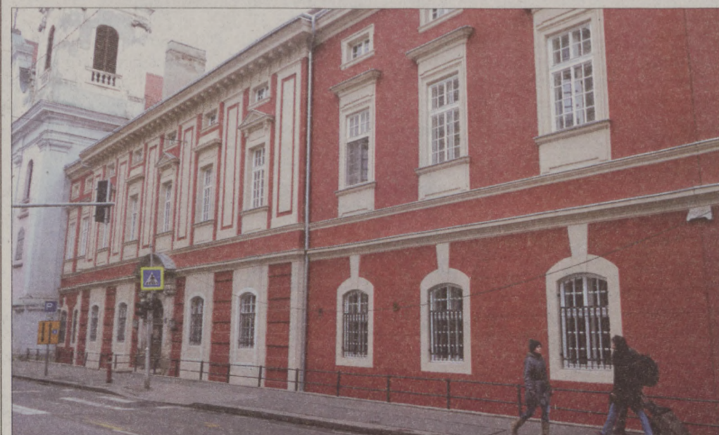
Megújult a Máltai Szeretetszolgálat Batthyány téri épülete. A homlokzat, a díszítések javítása és színezése, a vízszigetelés, továbbá a bádogozás és a nyílászárók cseréje 180 millió forintos kormányzati támogatásból és 23 millió forint önerőből valósult meg. A felújítás részeként elkészült az épület Batthyány tér felőli kerítése is.
