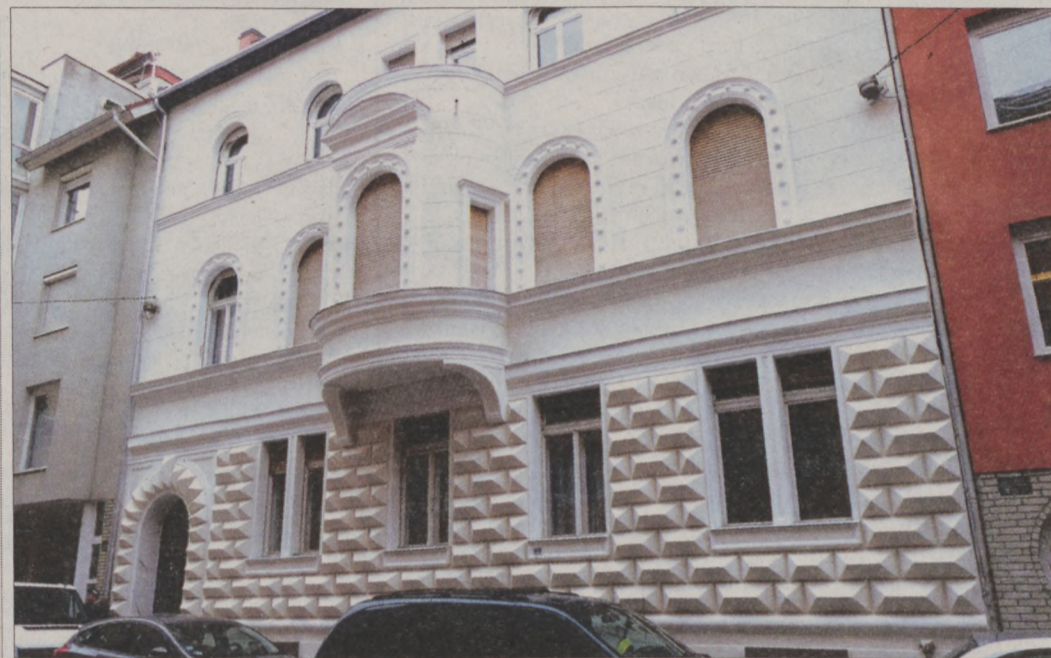
A Gellérthegy utca 19. számú társasház felújított homlokzata
