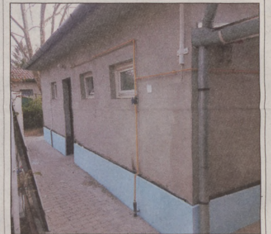
Felújítás alatt a vizesblokk Zamárdiban
