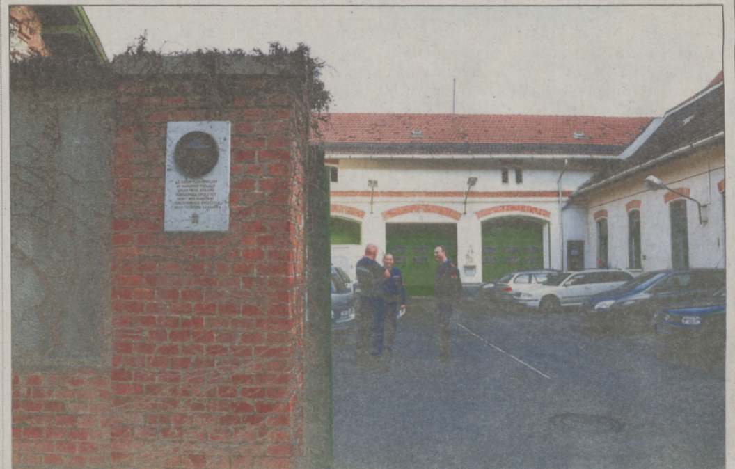
A Budavári Katasztrófavédelmi Őrs Kosciuszkó Tádé utcai épülete
