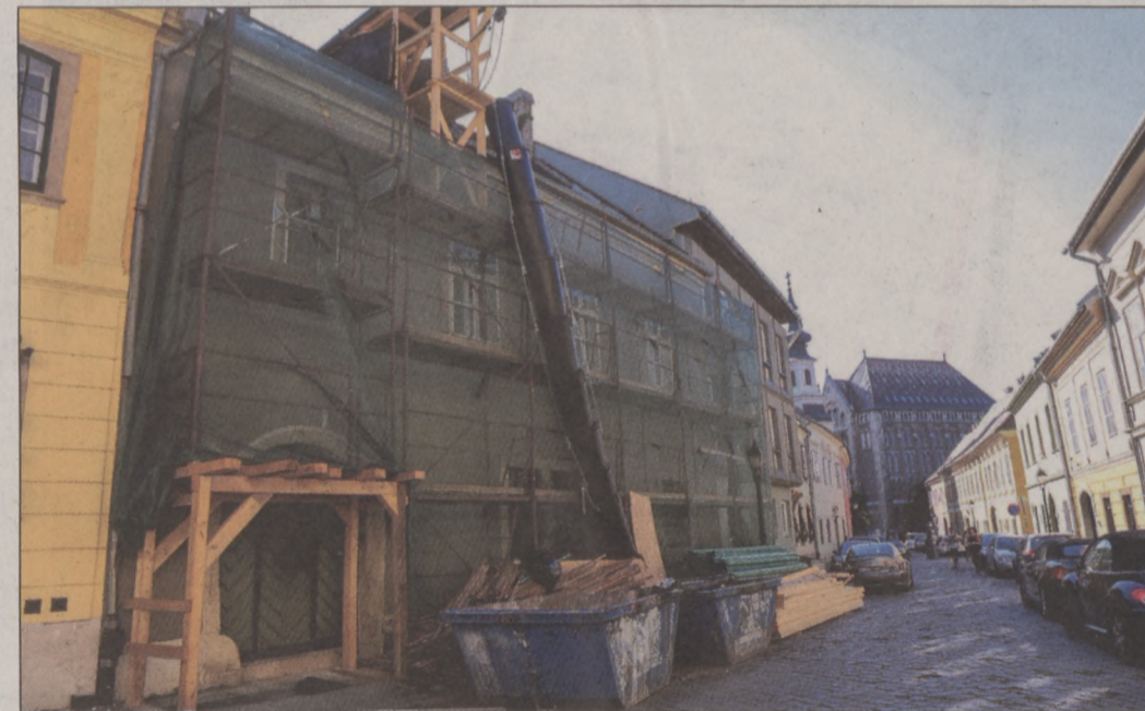
A műemlékházak felújítására évente többszáz millió forintot fordít az önkormányzat
