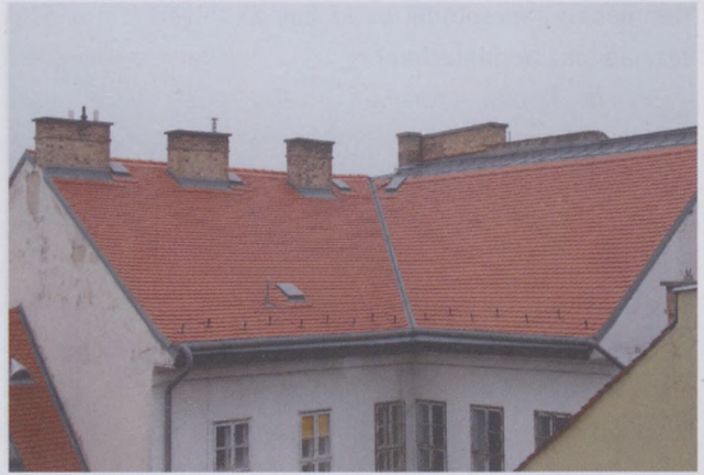
Üri utca 36. tetőfelújítási munkák
