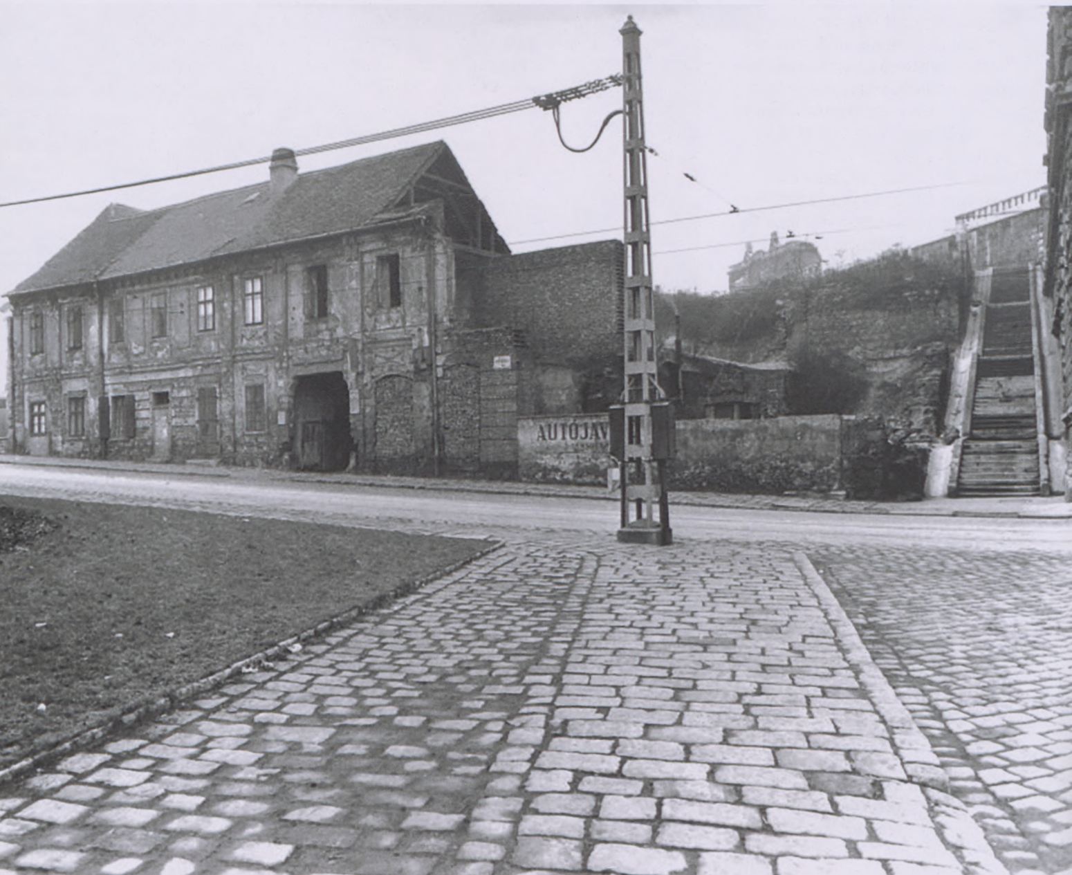
A ház a felújítás megkezdése előtt. (Forrás: fortepan.hu / BFL Városrendezési és Építészeti Osztályának fényképei)
