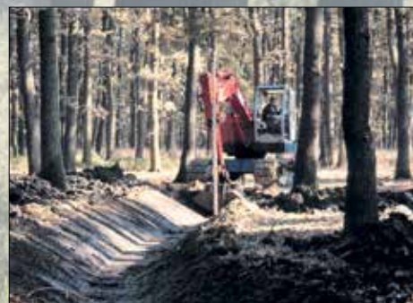
Készül a csatorna az erdőt éltető víznek
