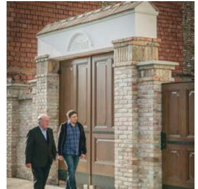
Elkészült a Pirók-ház kerítésének eredetihez hasonló kapuboltozata
