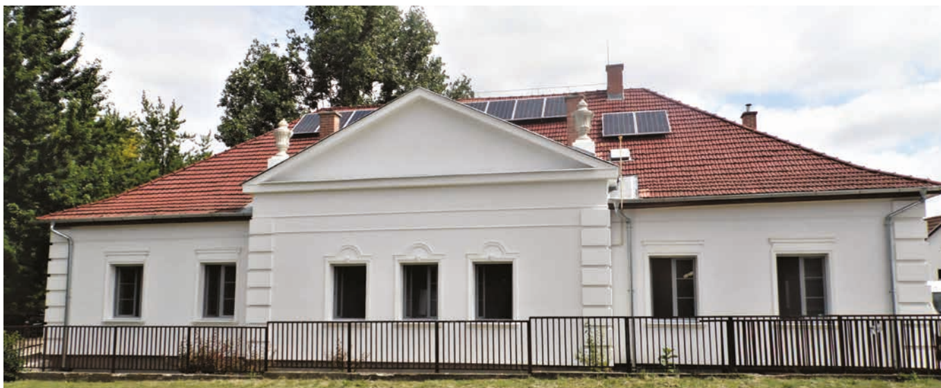
A konyha felújított épülete
