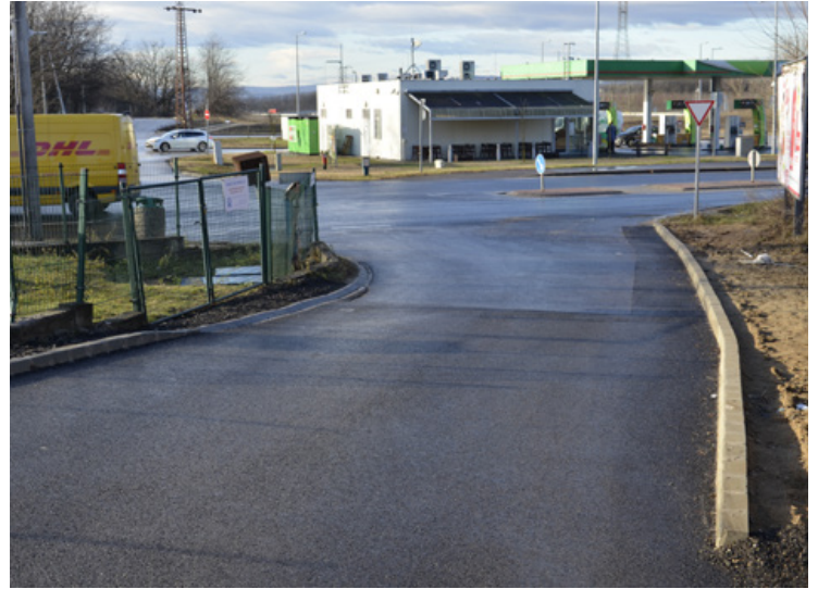
A Jedlik Ányos utca csatlakozása a Keleti Márton utcához
