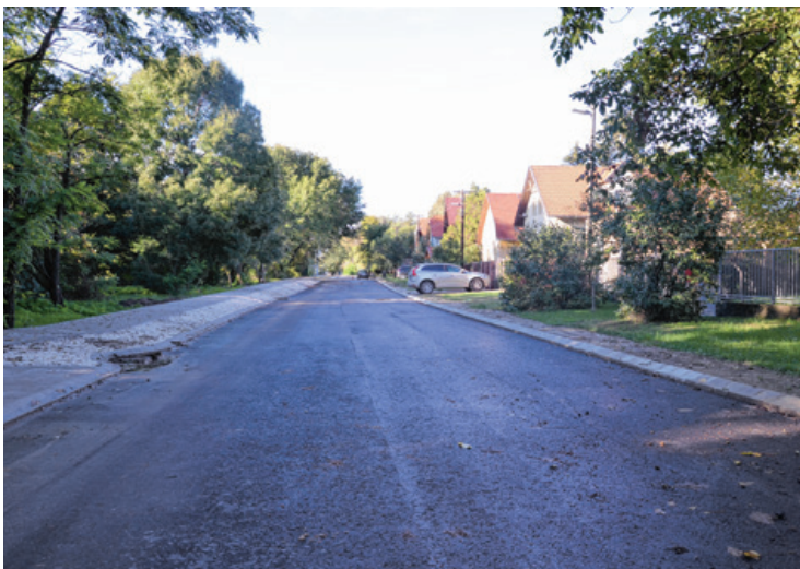
A járdával, gépkocsibeállókkal és csapadékvíz-elvezetéssel épült Hársfa utca
