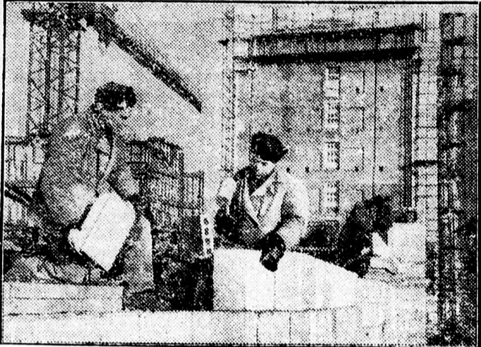
Képünkön Vaszilij és Szergej Piszkun kőműveseket látjuk, amint a szállodacépület külső falát újítja kerámialappal fedik be.
