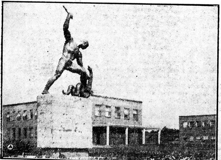
A mi hazánkban is hatalmas ütemben folynak az építkezések. Népi államunk nagy gondot fordít dolgozó népünk egészségére. Épülnek a kór-házak, orvosi rendelők. Képzünk a most felépült hajdudorogi gyógyszergyárat ábrázolja.
