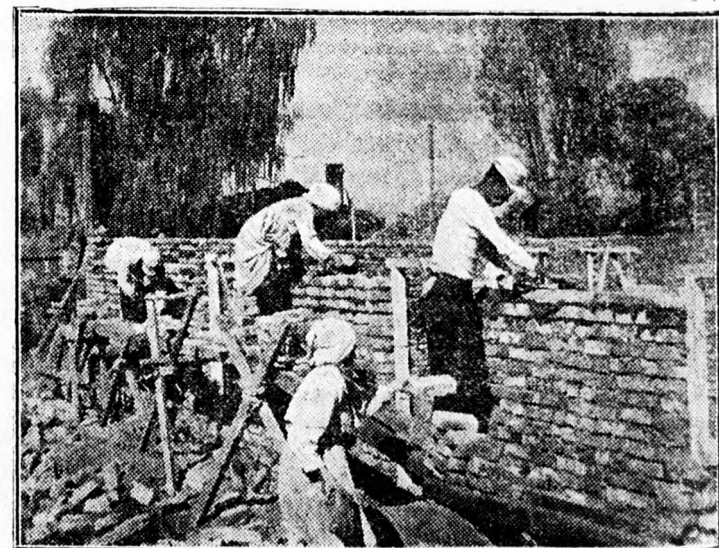
Munkásházak építése Phenjanban.
