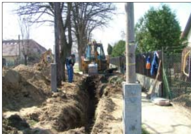
A bócsai Mayerffy utca csatornázása
